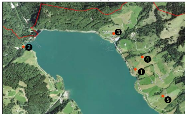
Abb. 8: Standorte KSI-Bauten in der Gemeinde Innerthal
