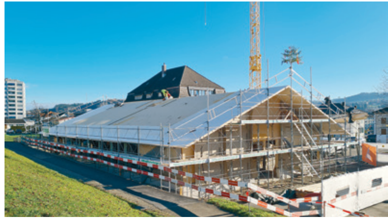
Baufortschritt Kindergarten Neugasse Bazenheid
