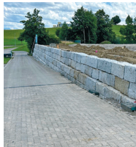
An der Stützmauer auf der Sportanlage Ifang werden Anpassungen vorgenommen.
