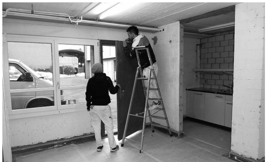
Im alten Militärkanntonement entstehen neben der Bibliothek auch Aufenthalts- und Garderobenräume für das Bauamtspersonal.
