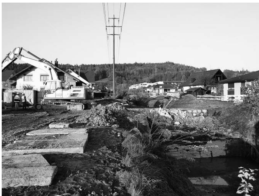
Im Spätherbst 2012 begannen die Ausbauarbeiten des Ernetschwilerbachs.
