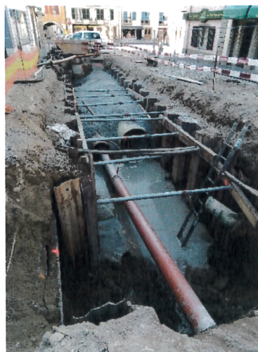
Vue partielle des infrastructures souterraines en cours de chantier
